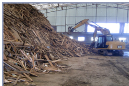
ストックヤードの様子
