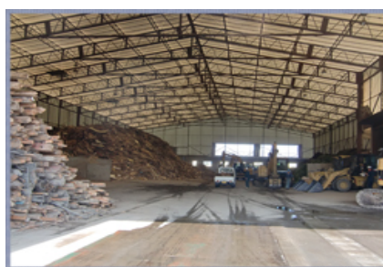
処理施設の全体写真
