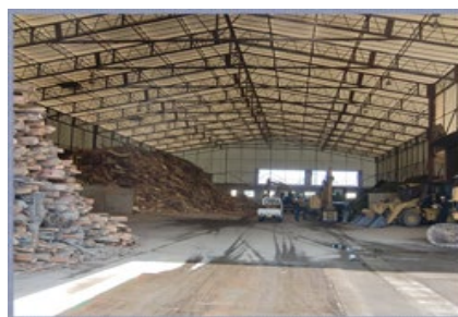
処理施設の全体写真
